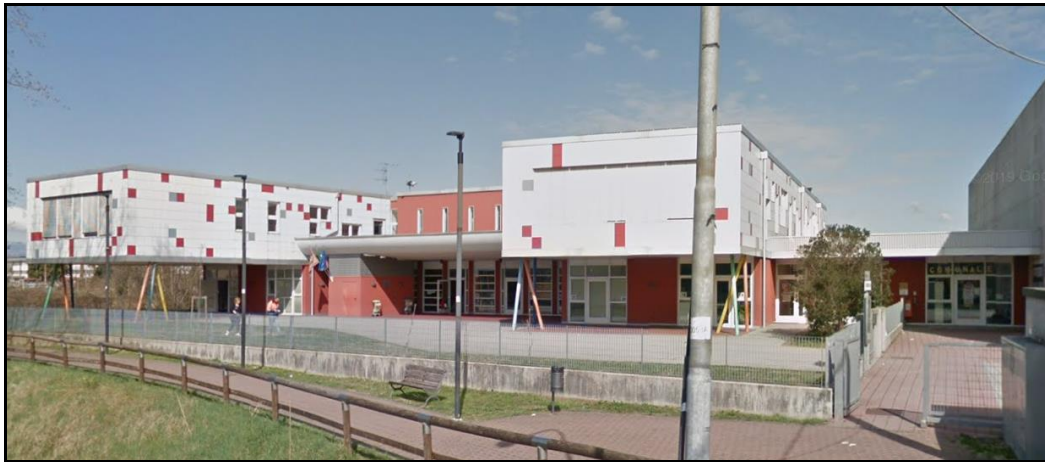
Vista edificio scolastico
