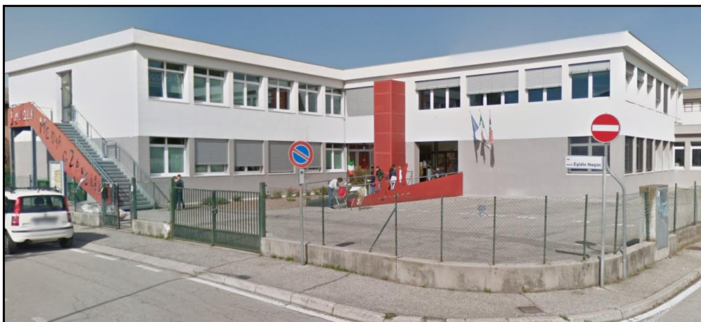
Vista edificio scolastico
