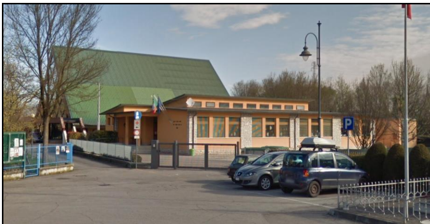
Vista edificio scolastico
