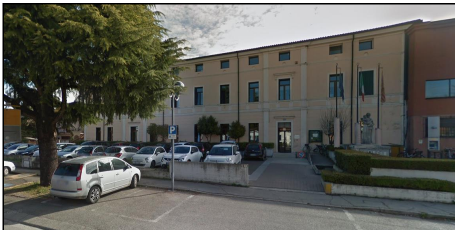
Vista accesso edificio scolastico da via Roma
